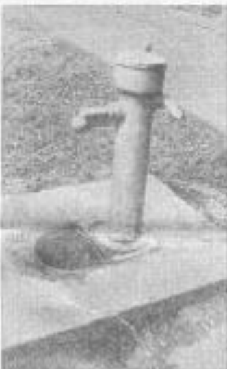
Bei diesem Hydrant gibt's sauberes Wasser.
