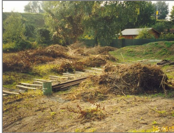
ÖBB räumen Bauplatz
