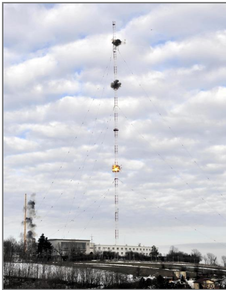
Sprengung des Nordmastes
