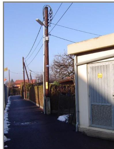
Niederspannungsfreileitungsnetz und Anschluss an Trafostation 1
