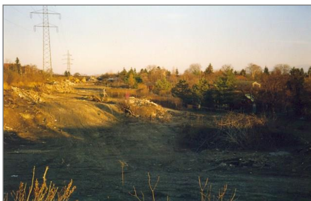
Erdaushub für den künftigen Marchfeldkanal (Blick von der Pragerstraße)
